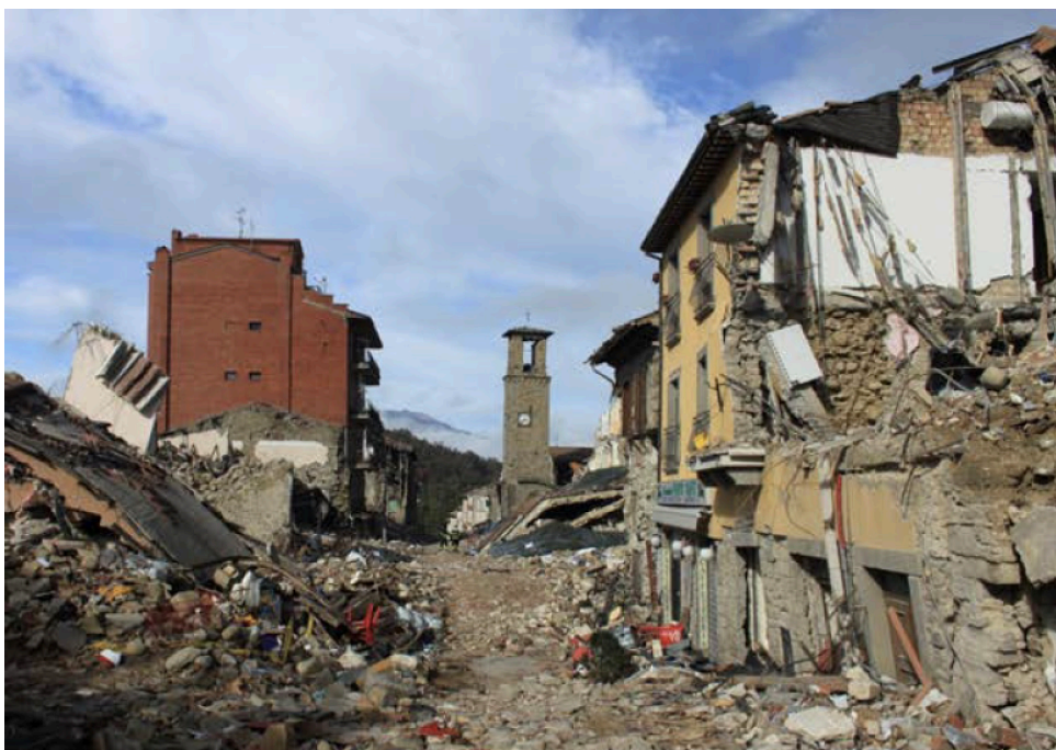
Vue d'Amatrice, Italie, après le séisme du 24-08-2016 (photo mission post-sismique AFPS)
