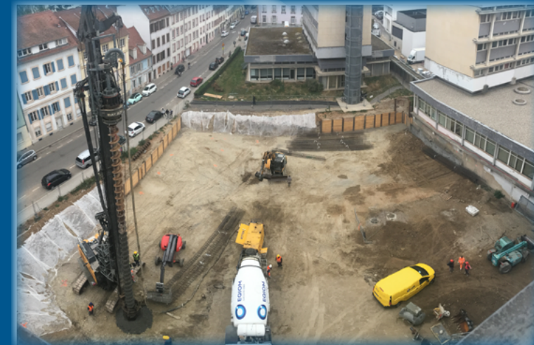
10 octobre 2018 - Forages pour la coulée des piliers de soutien du bâtiment
