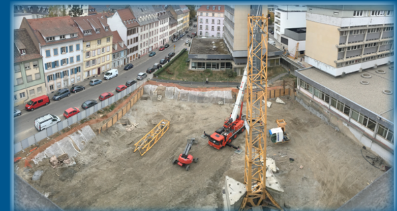
25 octobre 2018 - Montage de la grue
