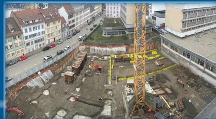
14 novembre 2018 - Premiers coffrages
