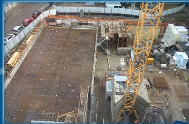
17 janvier 2019 - Premier niveau terminé
