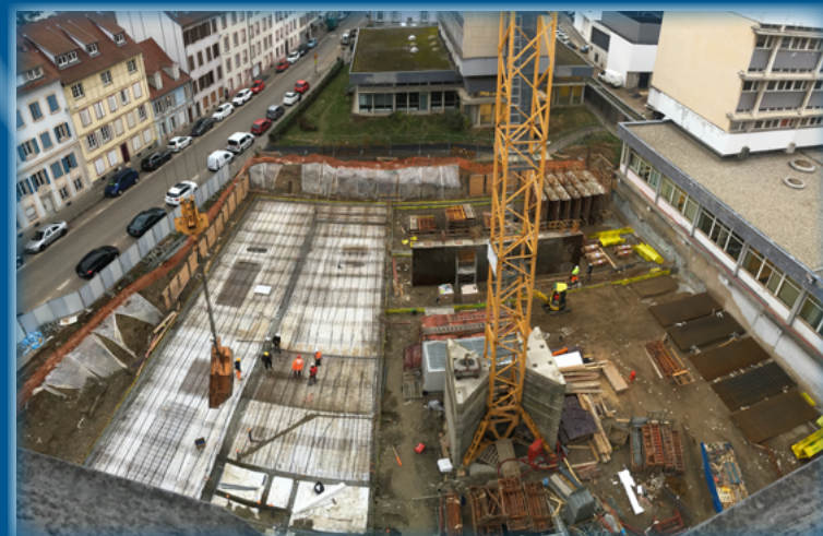
26 novembre 2018 - isolation du socle du bâtiment
