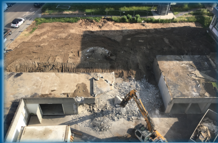
8 juin 2018 - Destruction des garages
