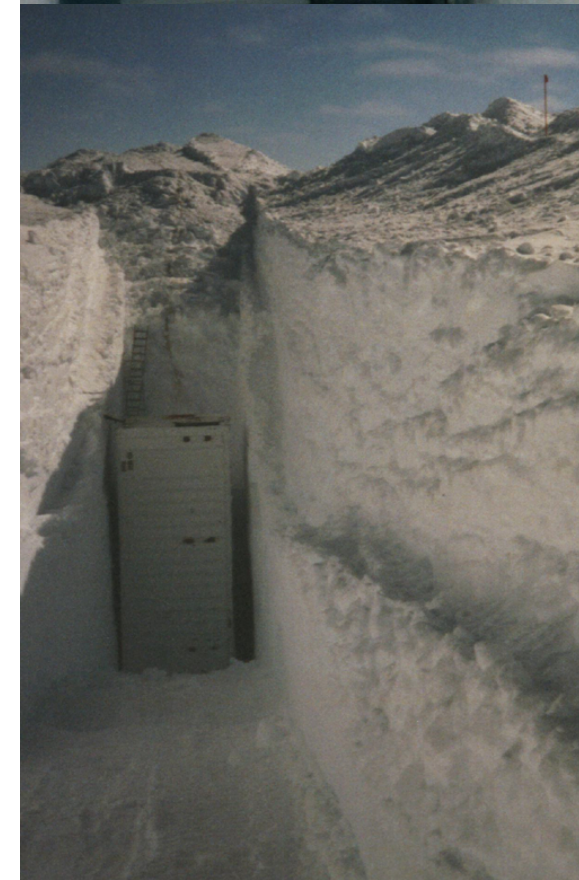
Photos de l'installation de la cave sismologique de Concordia
